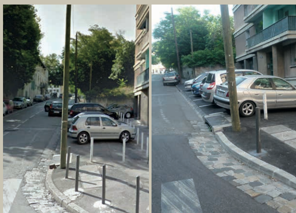
Réaménagement du trottoir traverse Bernabo - quartier Bernabo (15 e )
