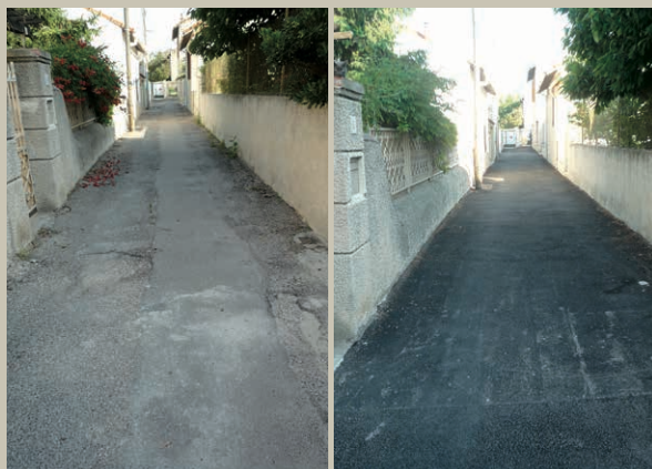
Réfection de la voirie boulevard Marius Rocchia - quartier la Viste (15 e )
